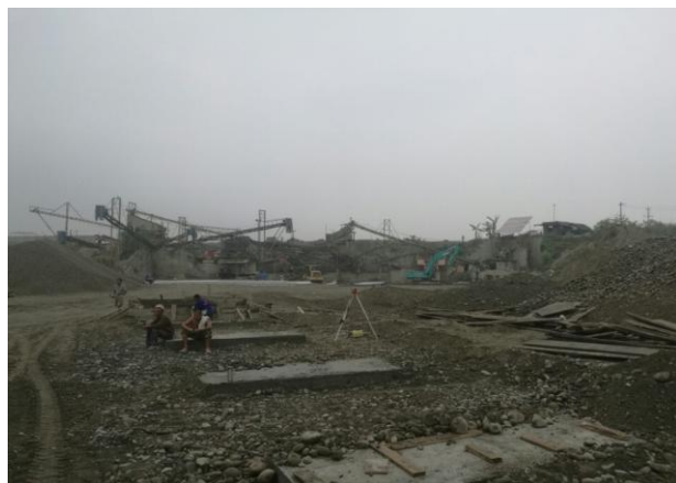
项目生产装置及现场
