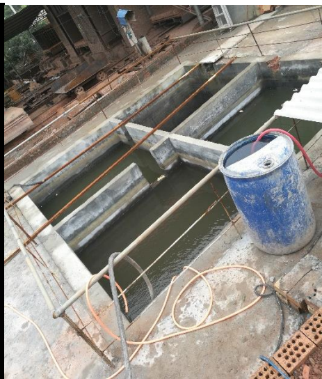
净化废水循环池
