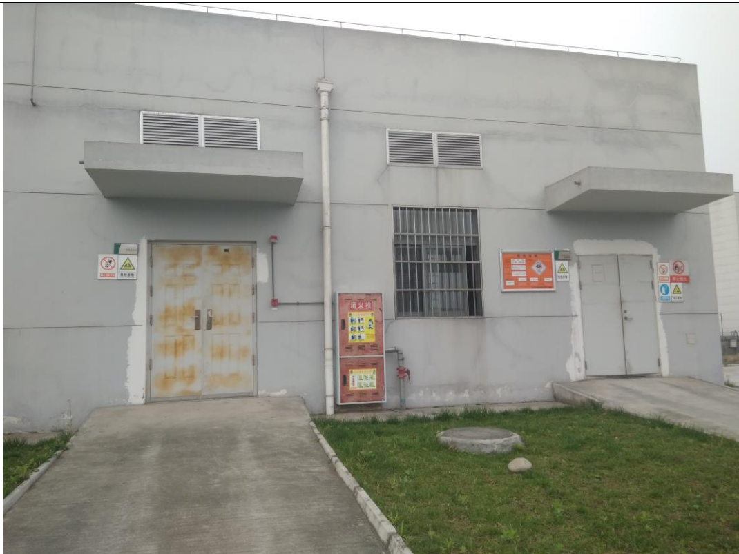
图 5-6 现有危废暂存库现场照片
