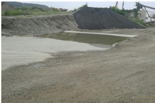
项目出入口洗车池
