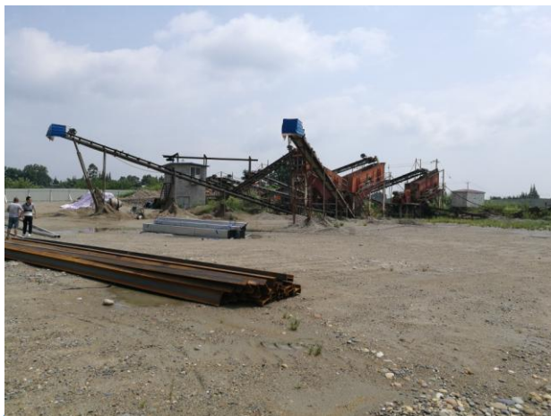
项目生产现场
