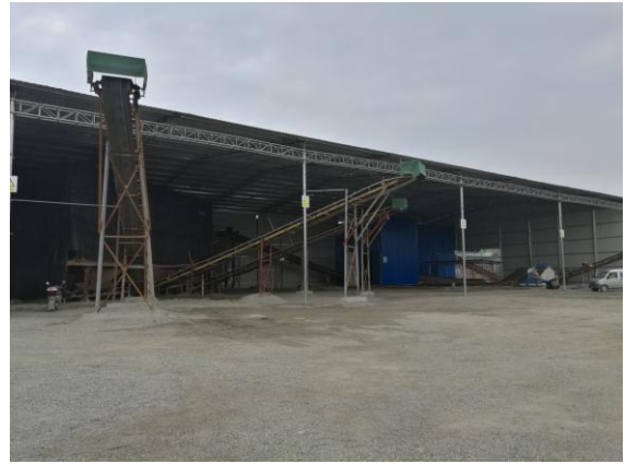
碎石料临时堆放场
